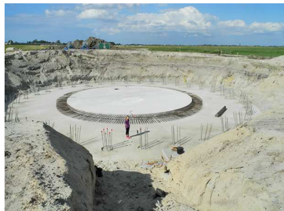
Abb. 2: Baugrube für Windenergieanlage © Manfred Knake
